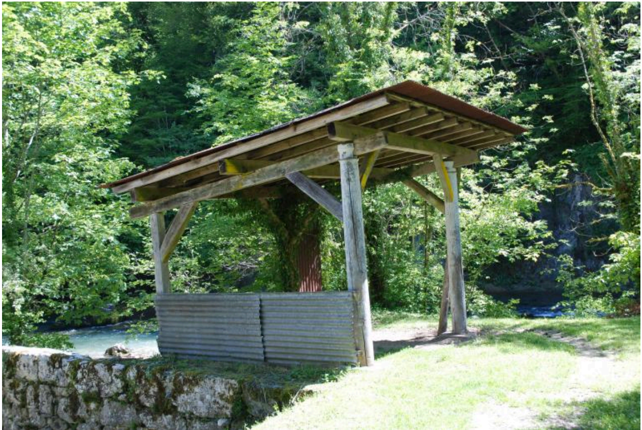
Vue de l'édicule en charpente au bord du Chéran.
