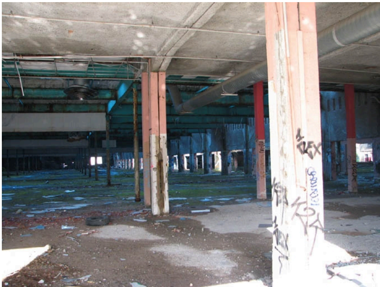
Vue des ateliers sheds (démolis)
