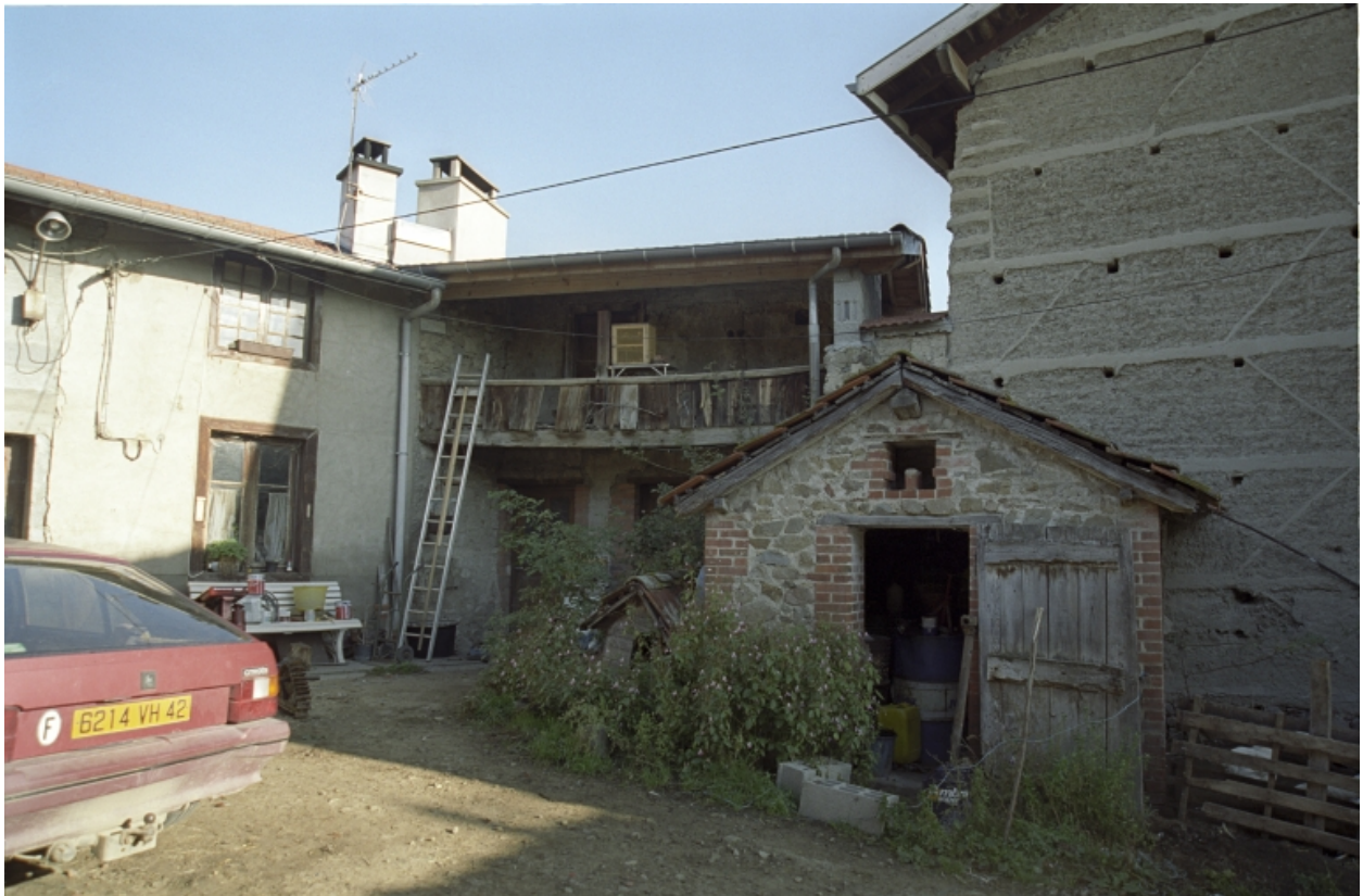
Vue de l'angle nord de la cour : angle du logis, bâtiment précédé d'une aître, porcherie, angle de la deuxième grange.
