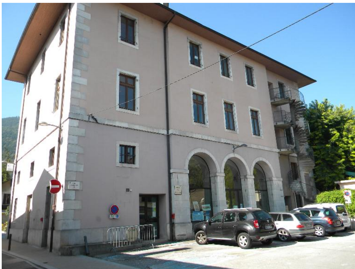
Vue de la façade arrière.
