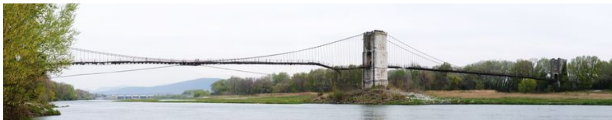
Vue panoramique, côté aval
