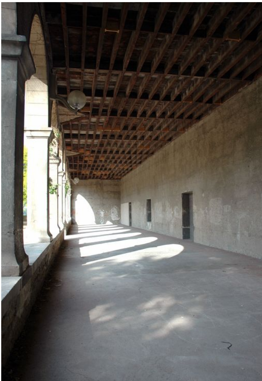
Bâtiment de la galerie, vue du portique depuis le nord-est
