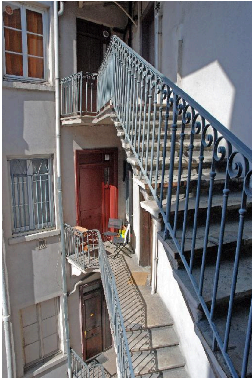
Vue des volées d'escalier desservant le corps de bâtiment en retour
