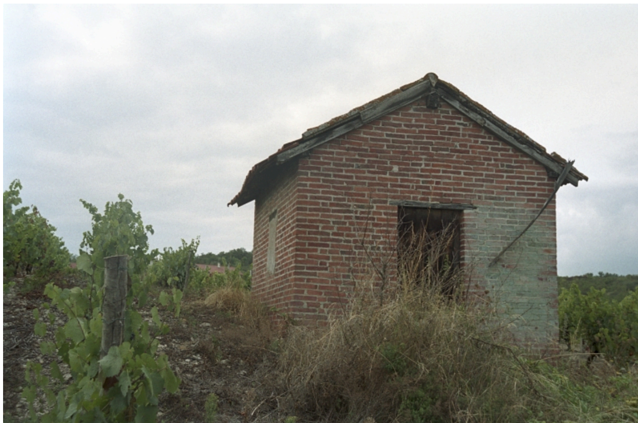
Boën, La Moresse (1986 AC 229). Loge en rez-de-chaussée de type R3a1. Vue d'ensemble.
