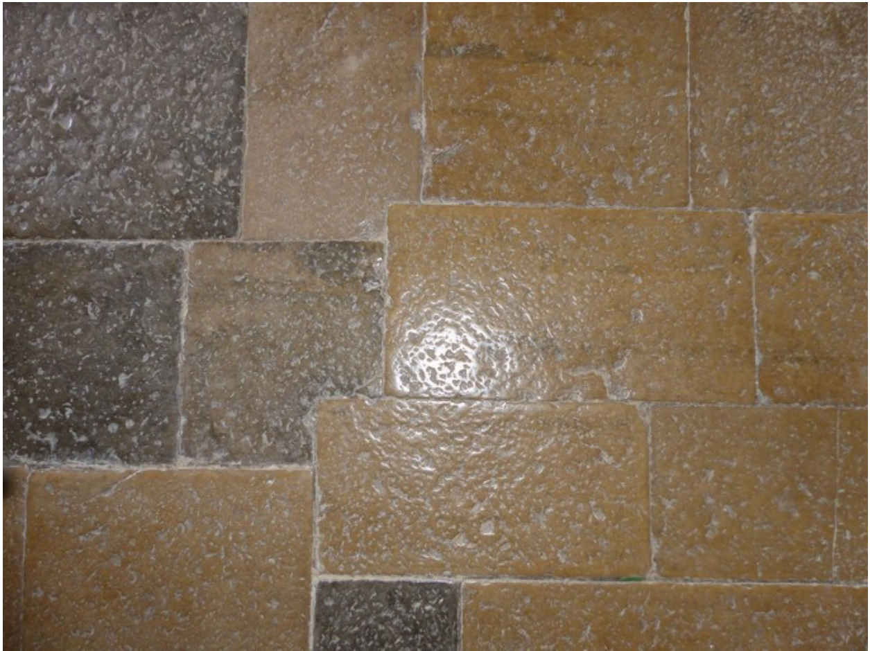
Bâtiment principal. Troisième étage de soubassement, cuisine. Sol en dalles calcaires.
