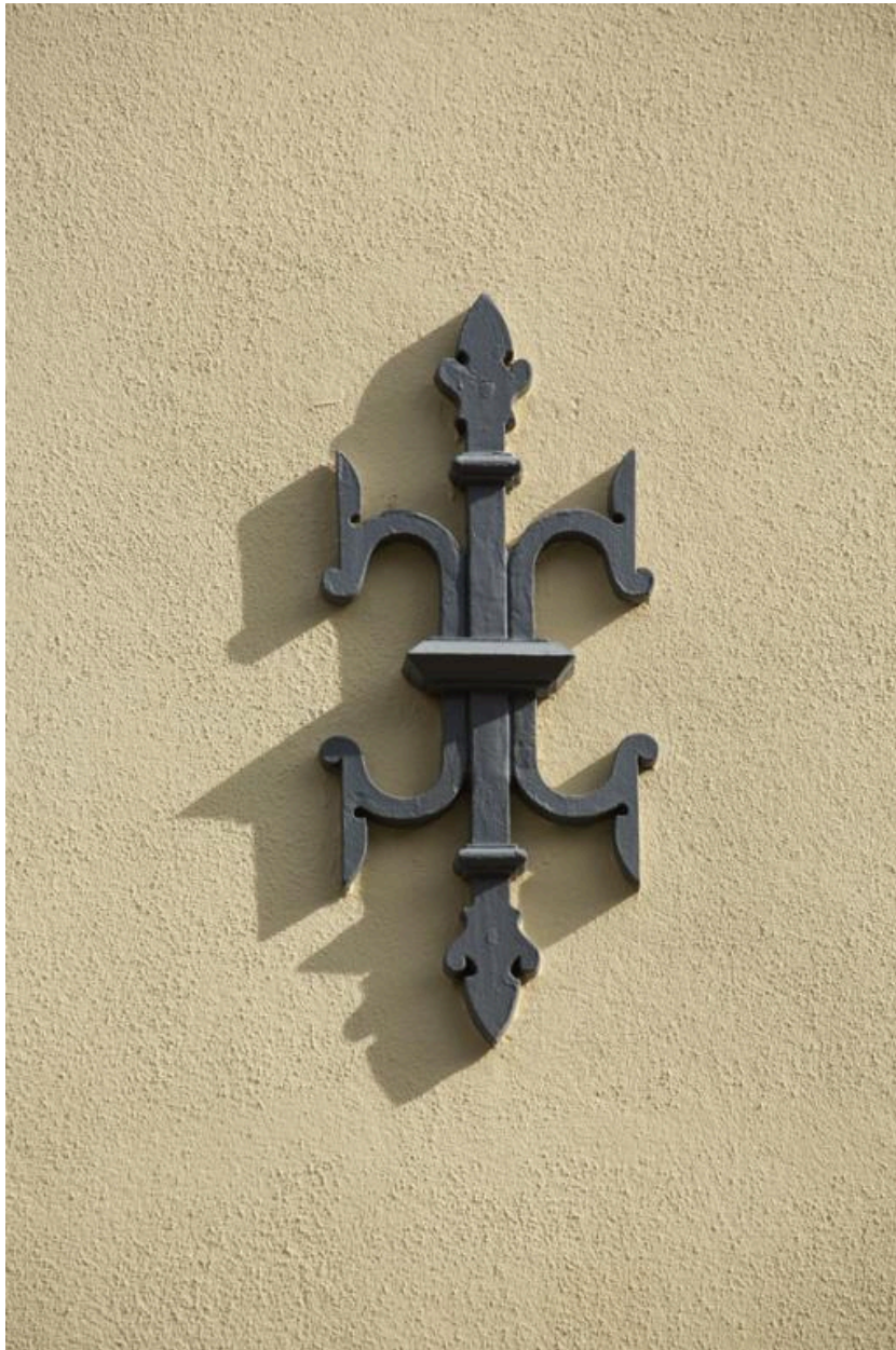
Aile Marcoz, détail d'architecture, clé de tirant.
