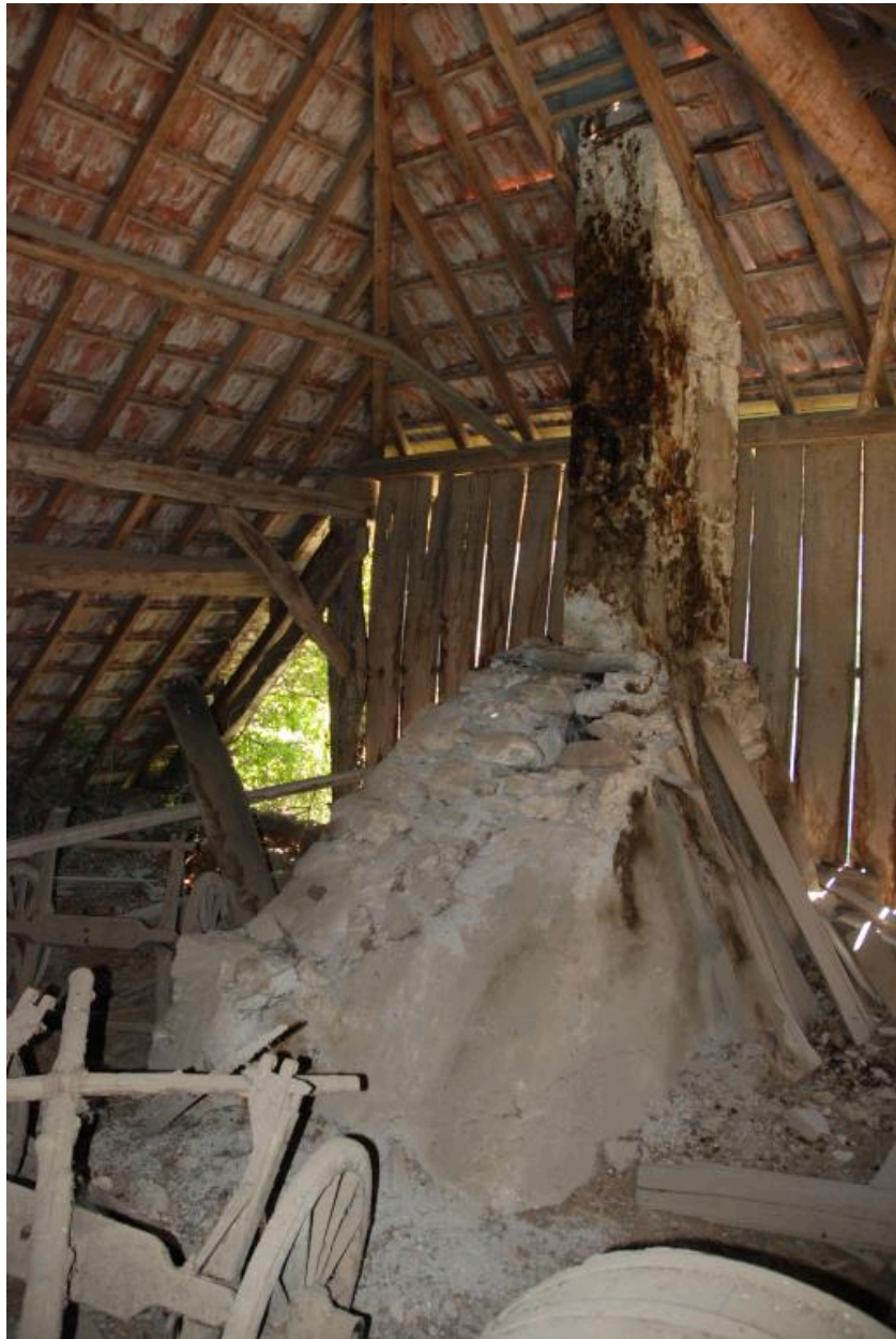
Vue de la souche de cheminée dans le comble.
