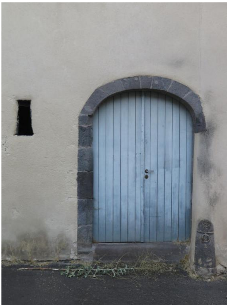
Accès au cuvage et chasse-roue
