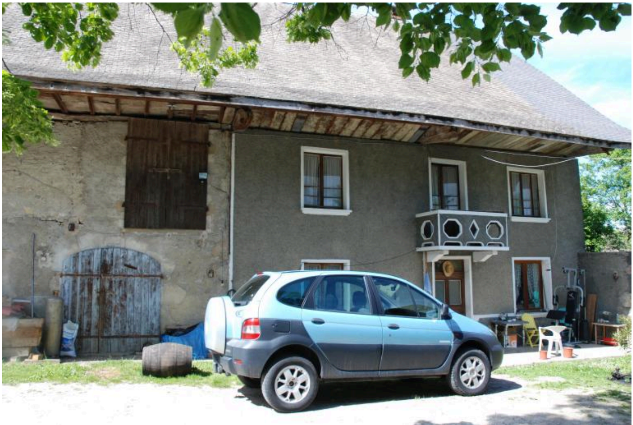
Vue d'ensemble, partie habitation.
