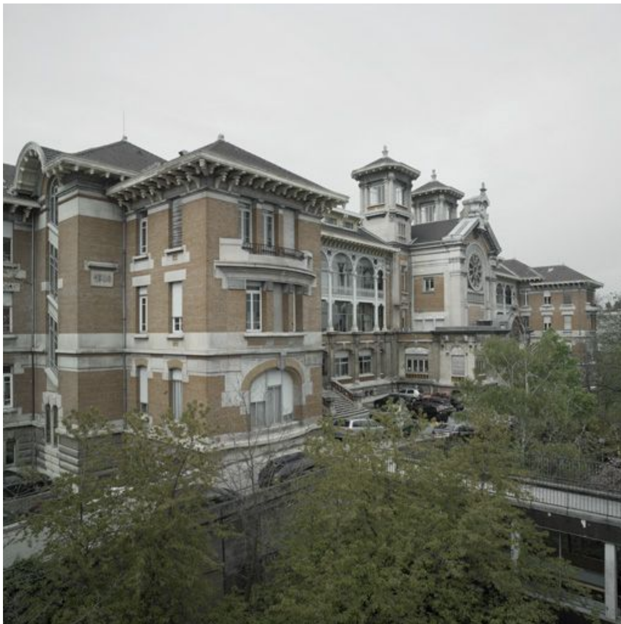
Bâtiment B, vue d'ensemble de la façade principale, prise depuis la terrasse du bâtiment A
