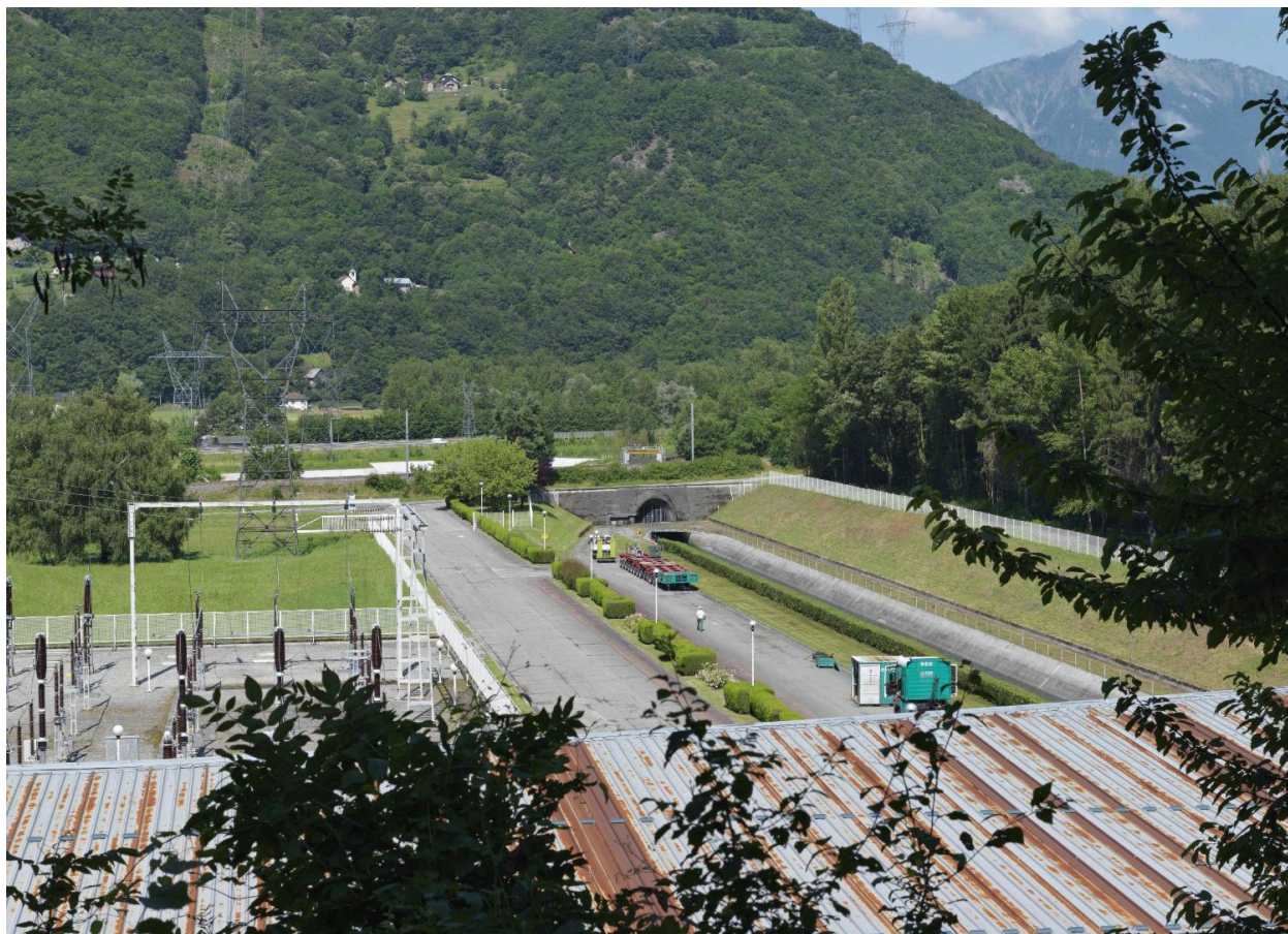
Canal de fuite de la centrale
