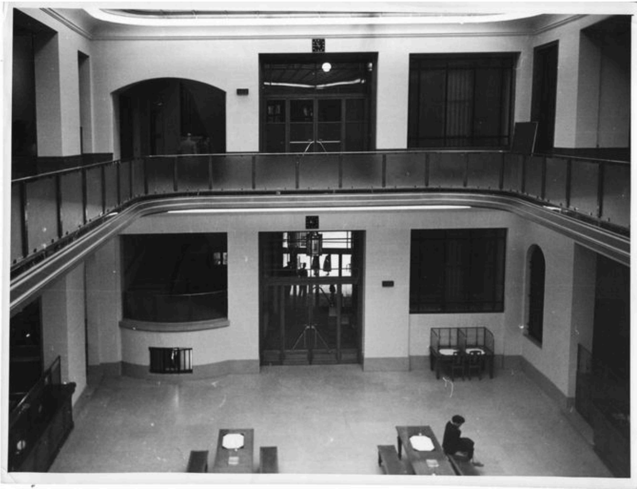
Vue du hall du public du côté de l'entrée (la verrière a été remontée d'un niveau) en 1959-1960 (Banque de France, archives historiques, 1Fi 0497-17, photographie).
