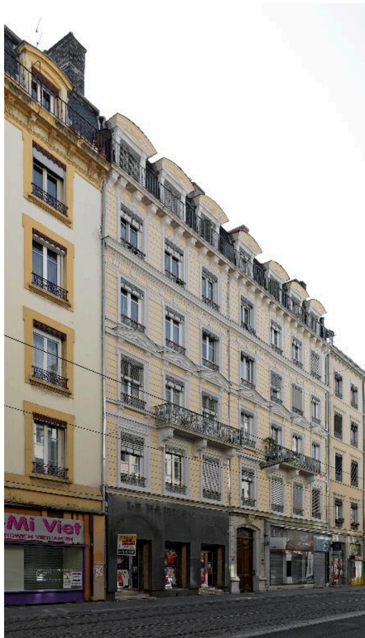
Elévation antérieure, rue de Marseille
