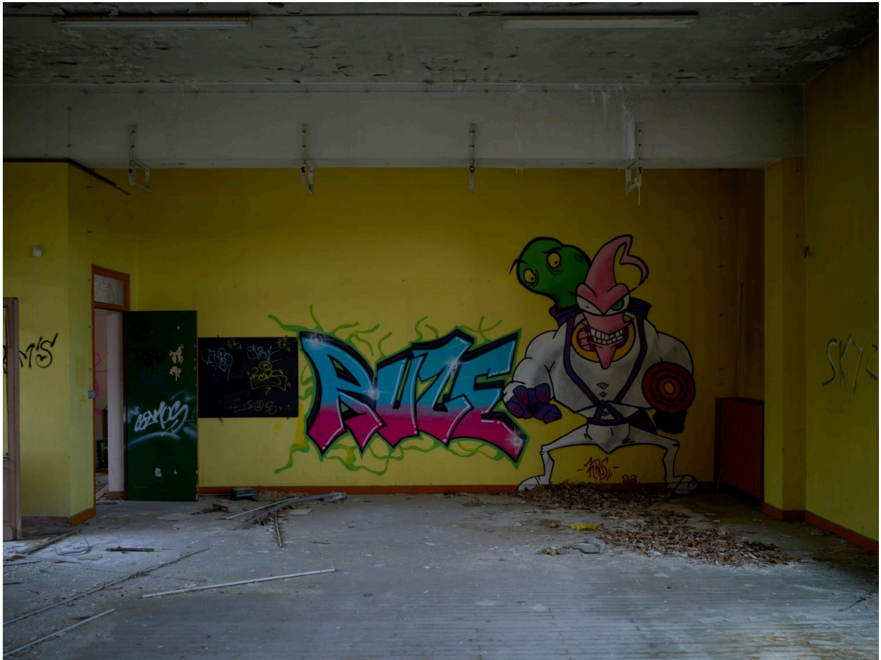
Mur sud du gymnase. Peinture murale.
