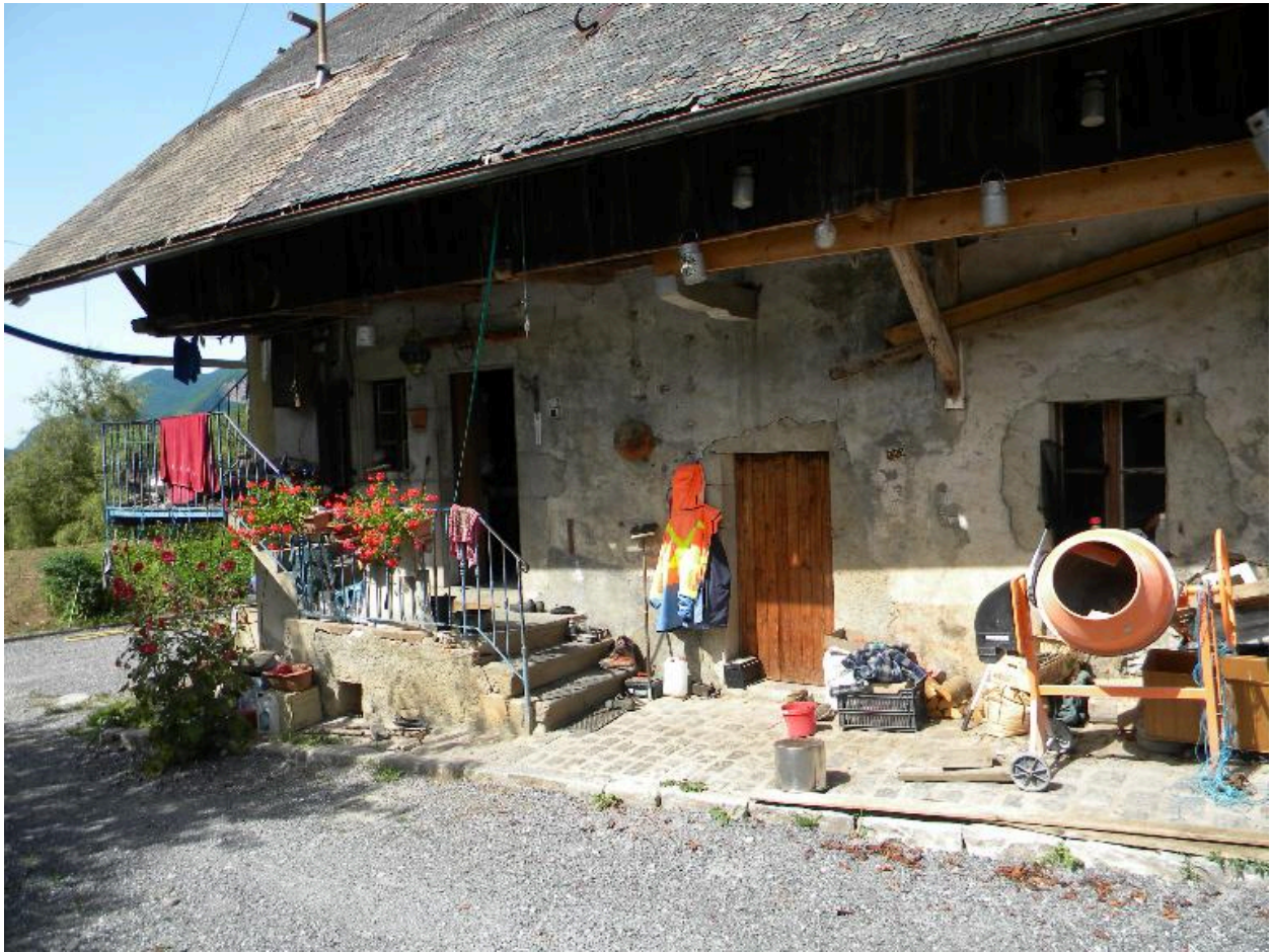
Vue de la façade principale de la ferme.
