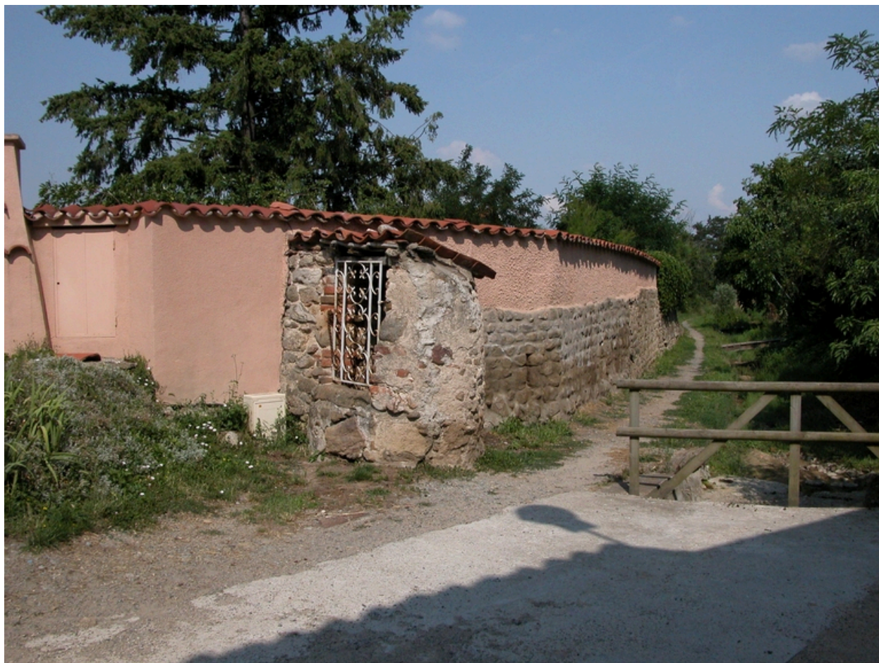
Puits à l'Écharavet, impasse de l'Écharavet (1999 AE 35).
