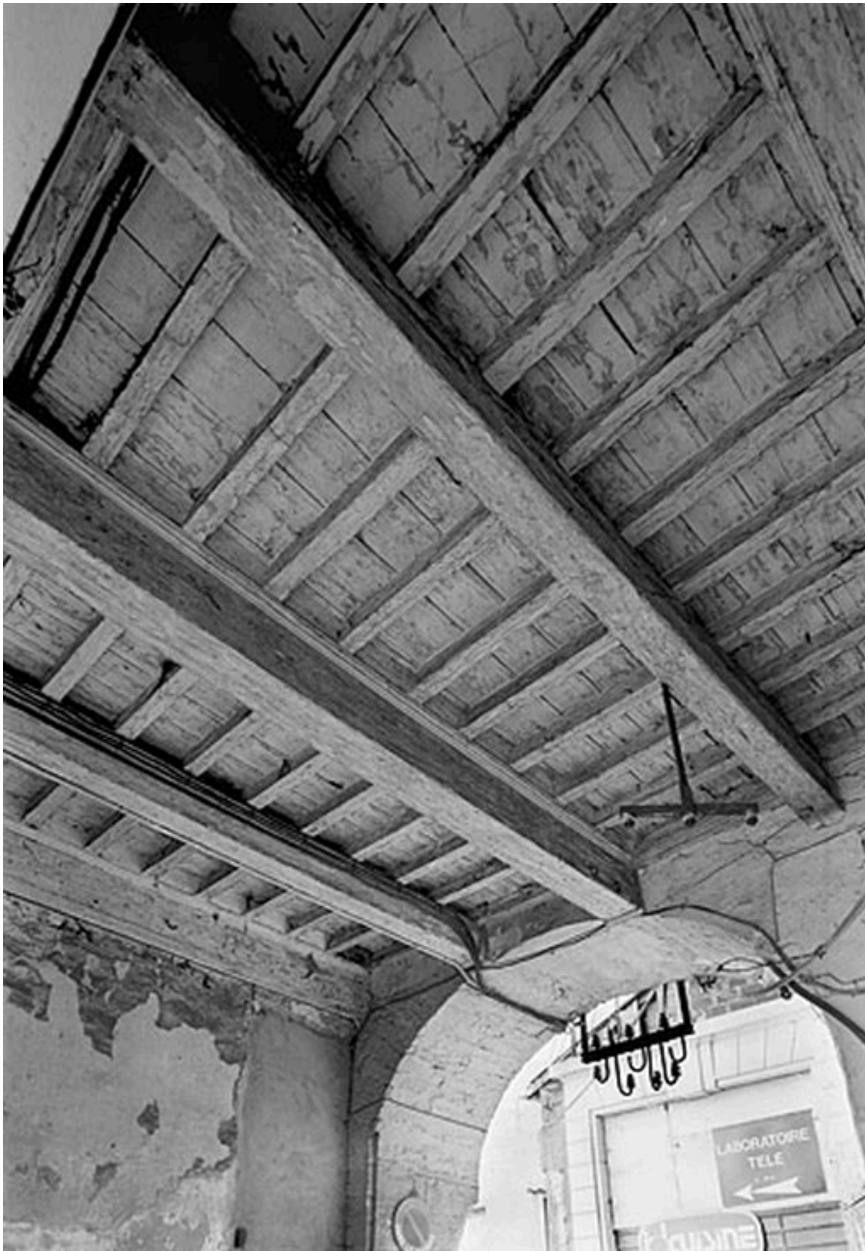
Plafond à poutres du corps de passage
