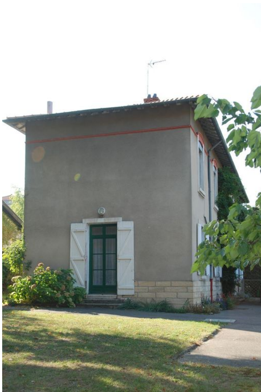
Bâtiment 222, façade latérale nord
