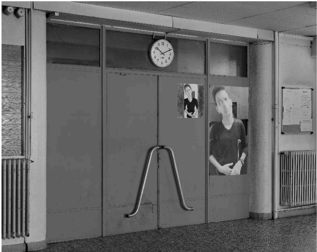
Vestibule : porte d'accès à l'ancien garage à vélos, aujourd'hui débarras
