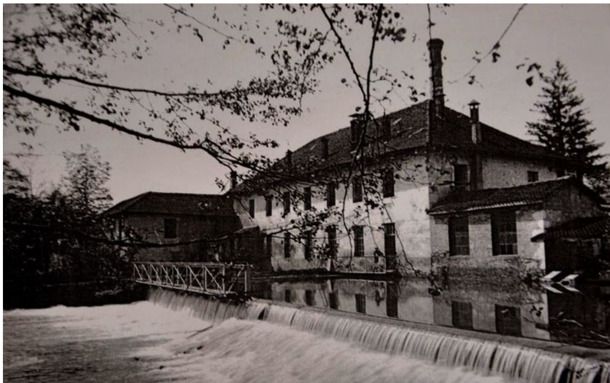
Vue de la Cartonnerie Mercier, 1910 - 1920. Photo. Archives municipales de Cran-Gevrier © Archives municipales de Cran-Gevrier. Dossier Cartonnerie Aussedat
