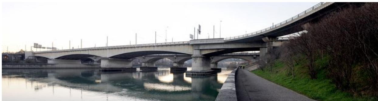
Vue panoramique, face amont (depuis la rive droite)
