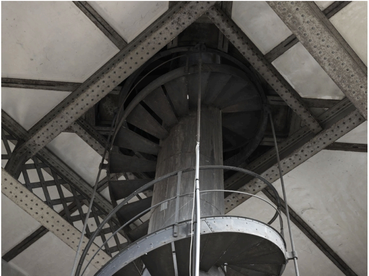
Le dôme Pascalon. Le haut de l'escalier métallique du 1er étage
