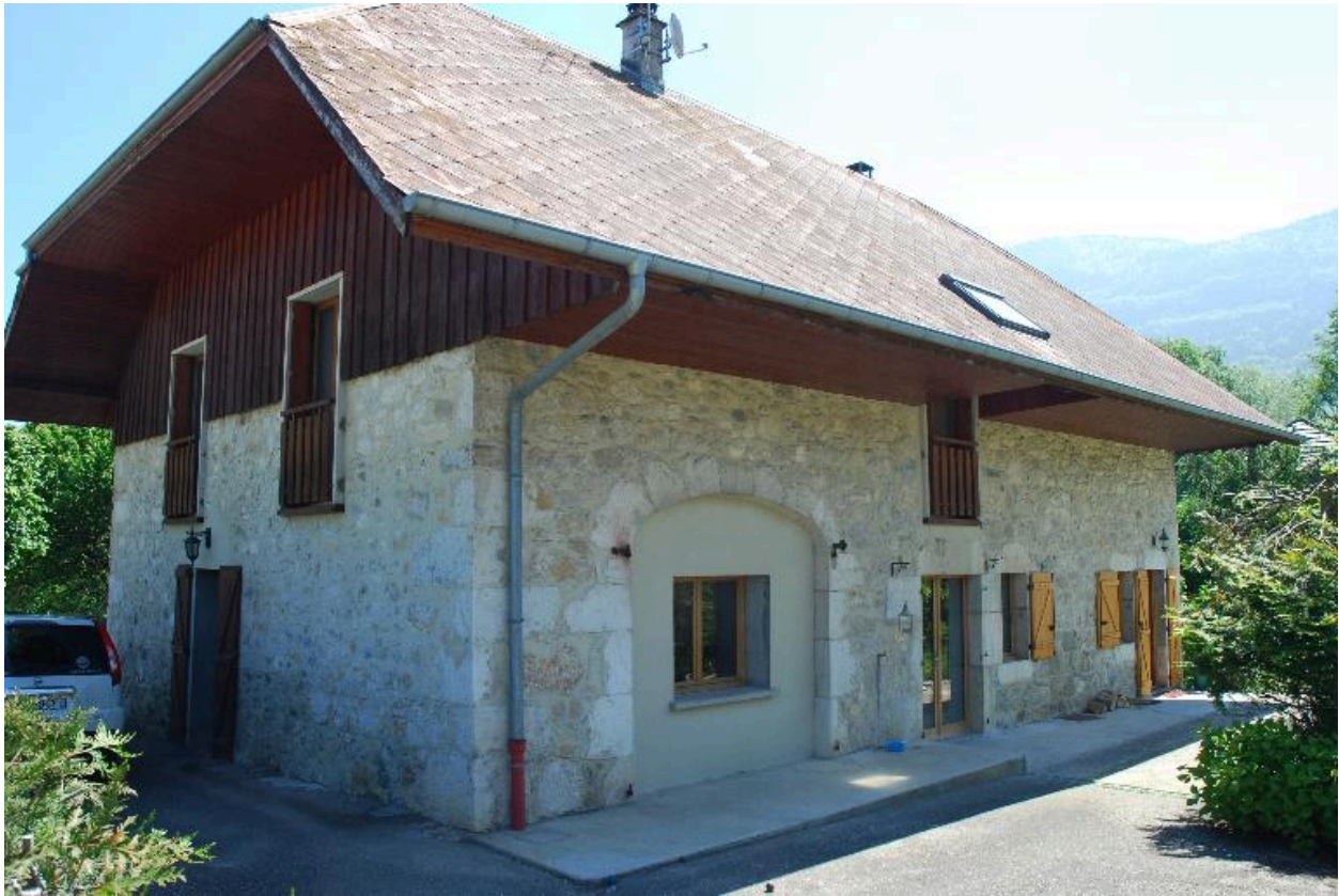
La Plesse, ferme (2013 D2 197), vue d'ensemble de la façade avant, de trois quart.
