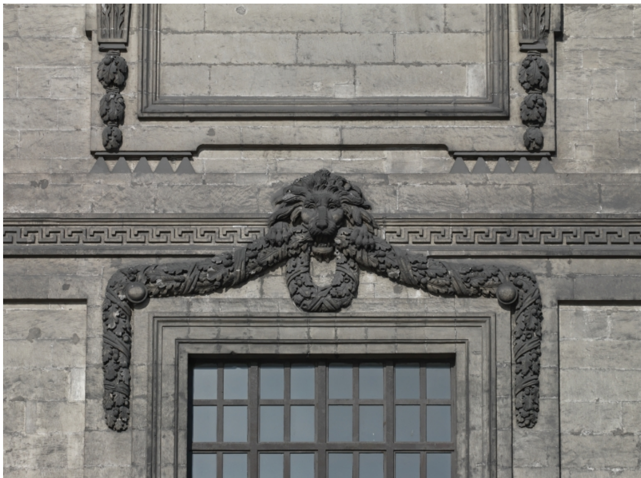
Le dôme Soufflot. Façade orientale. Larmier de fenêtre
