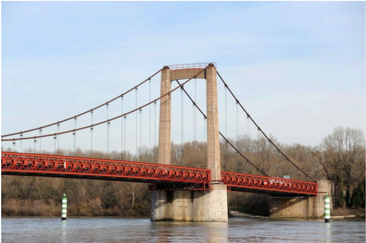
Vue partielle, culée et pile gauche, face aval (depuis la rive droite)
