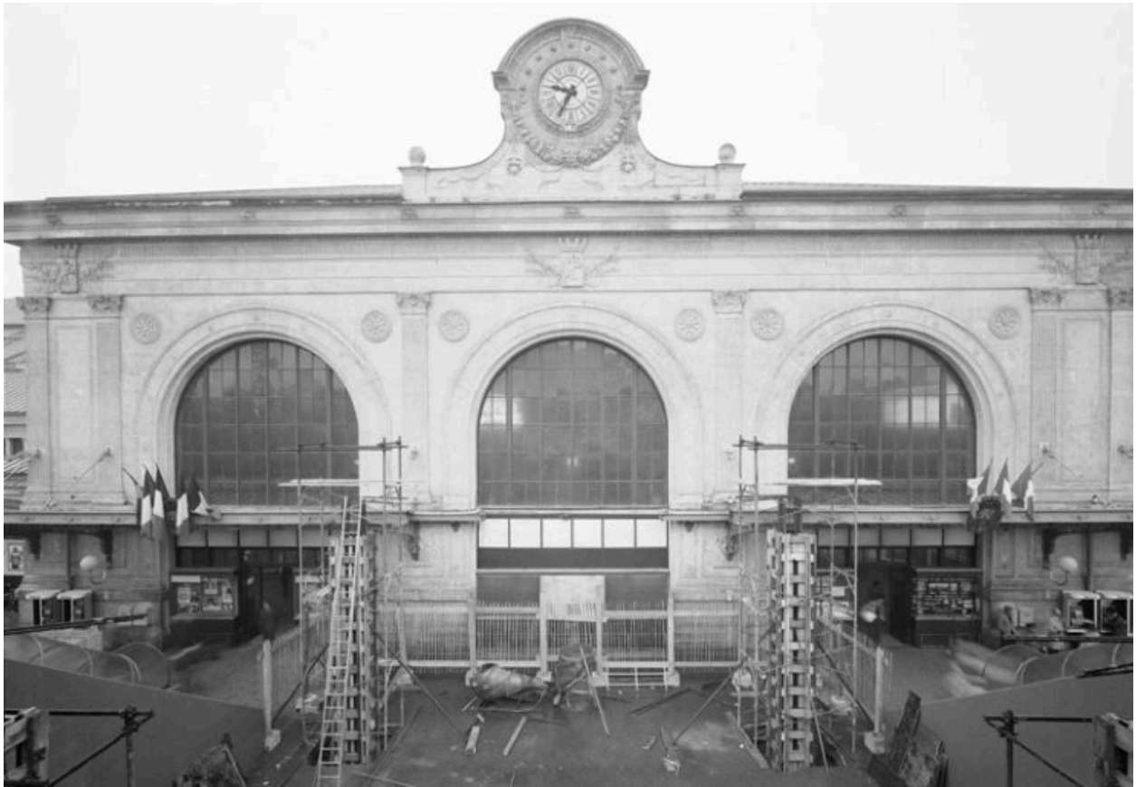
Elévation antérieure du corps de bâtiment principal, état en 1980
