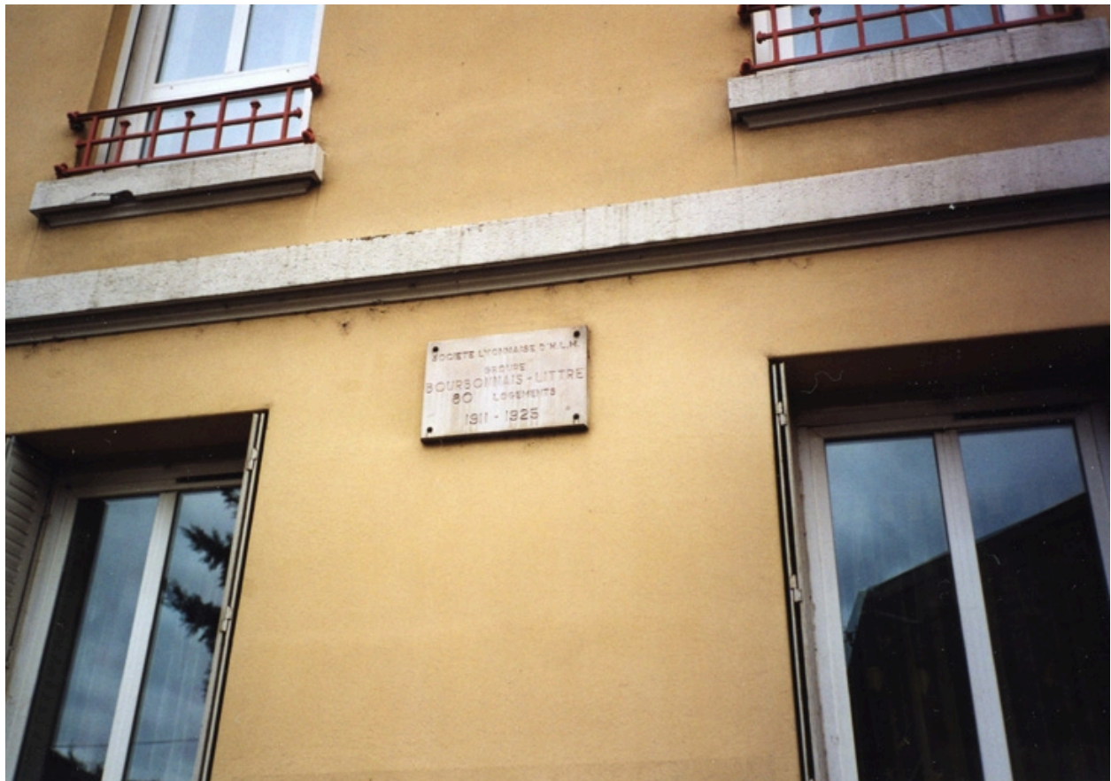
Vue nord, 55, 53, 51 rue du Bourbonnais (BP 138), enseigne sur façade principale : 'Société Lyonnaise d'HLM, groupe Bourbonnais-Littré, 80 logements, 1911-1925'
