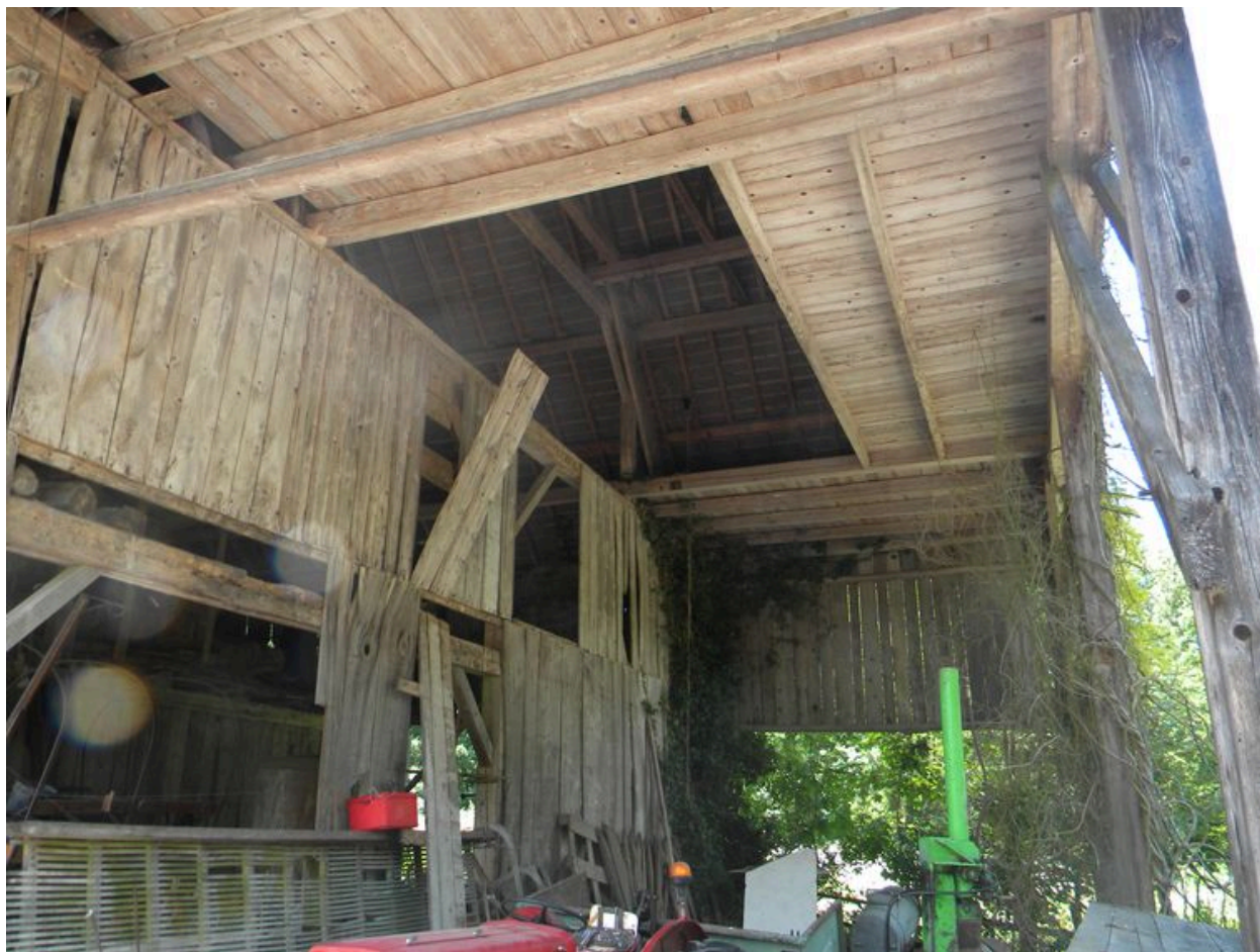
Ouverture dans l'avant toit pour le monte foin.
