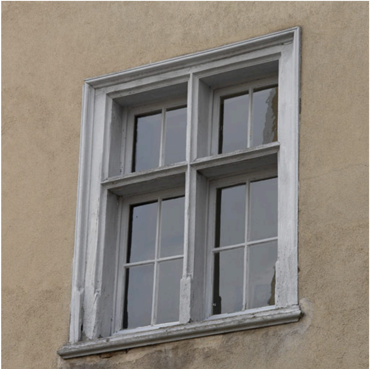
Détail d'une fenêtre à meneau en bois de la façade sur cour de l'aile sud (1er étage, fenêtre ouest).
