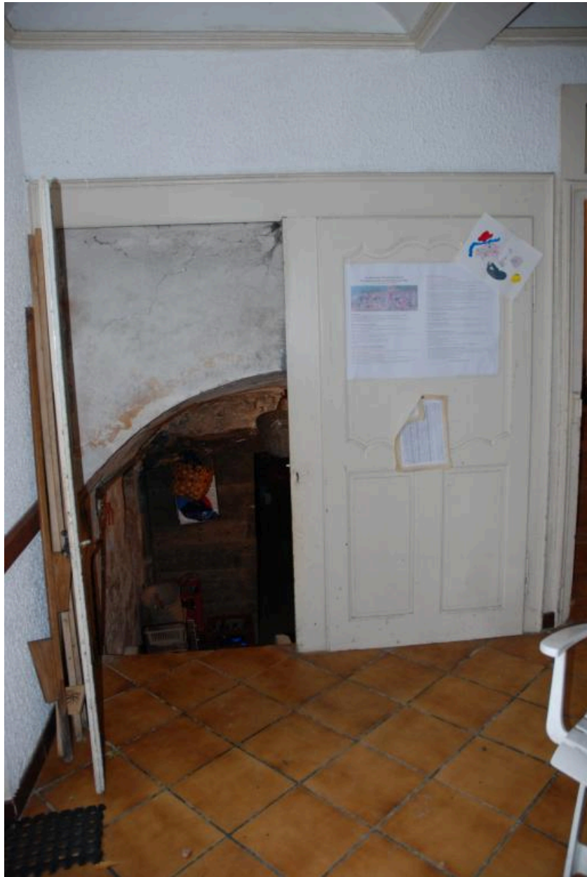
Corps principale, rez-de-chaussée, partie sud, salle à manger (Cf. Plan RDC 8b), vue d'ensemble de la double porte ouvrant sur l'accès aux caves voûtées.
