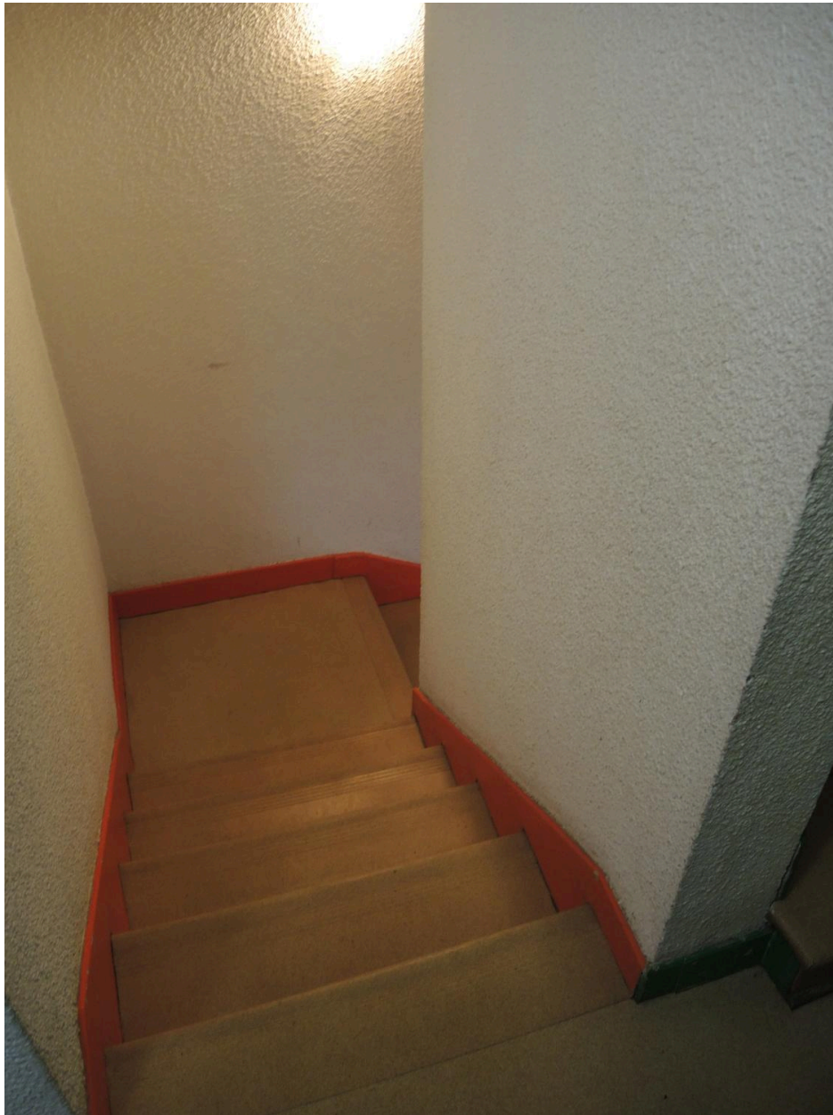
Vue des escaliers
