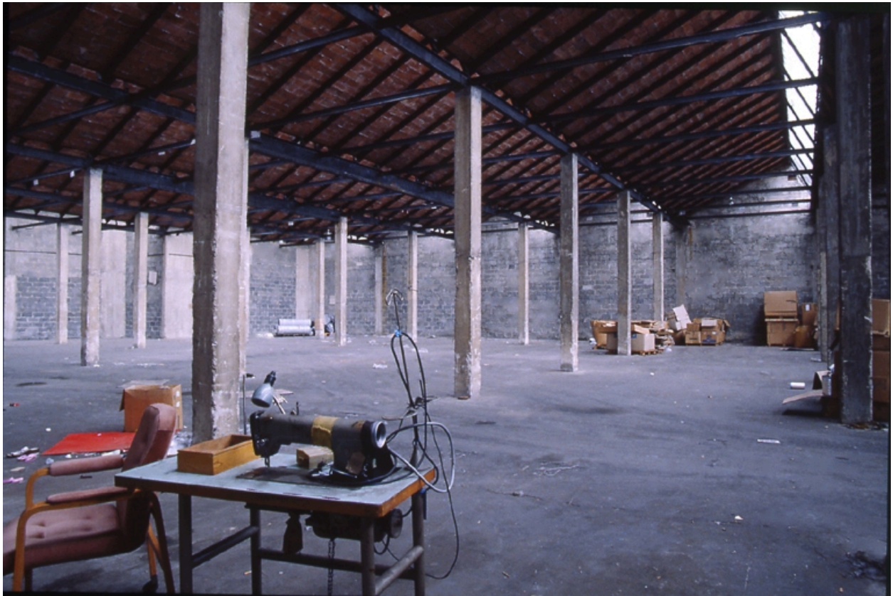
Vue intérieure atelier sheds
