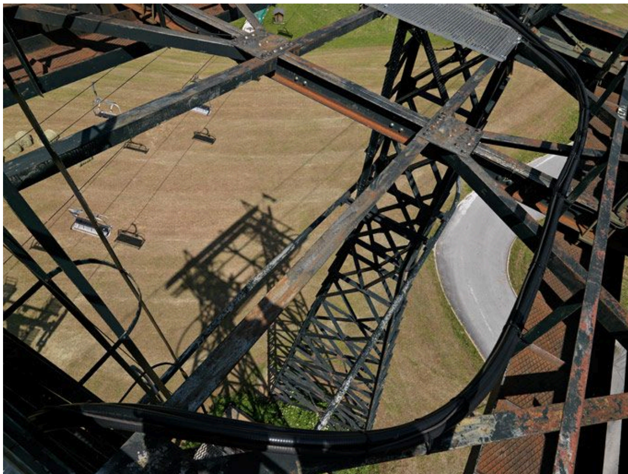
Détail du pylône
