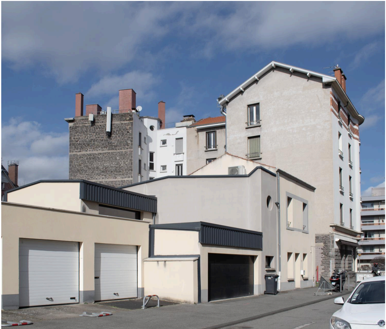
Élévations postérieures depuis la rue Gourgouillon
