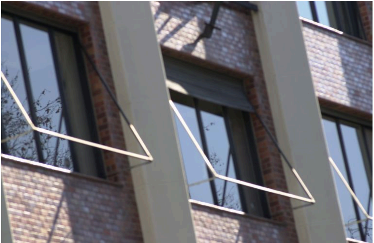
Détail des baies du troisième étage
