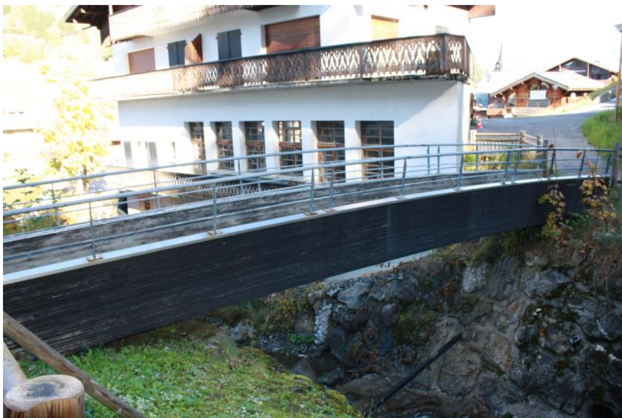
Passerelle de Carry, contexte et vue amont
