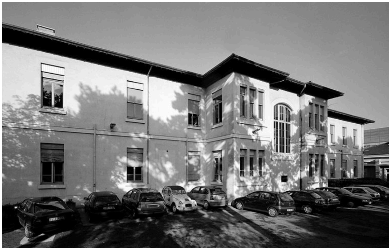
Bâtiment RST, aile T, élévation est
