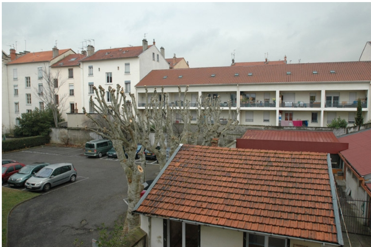
Entrepôt et parking, vue sud ouest.
