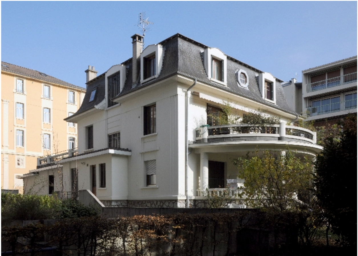
Vue depuis l'arrière
