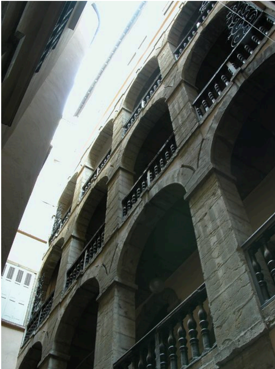
Cour : vue générale de la cage d'escalier
