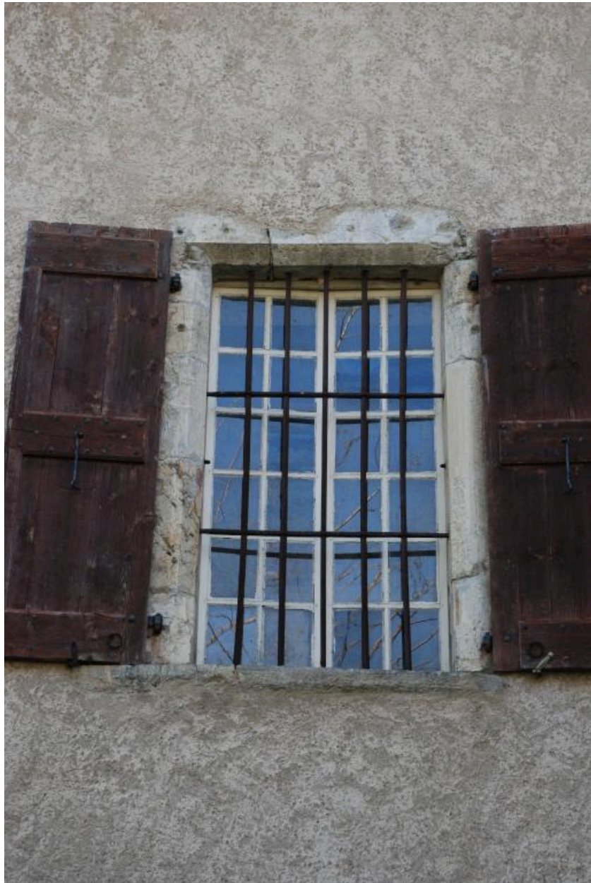
Façade arrière du corps de bâtiment principal (orientée à l'est), détail de la baie à cavet située à l'étage.
