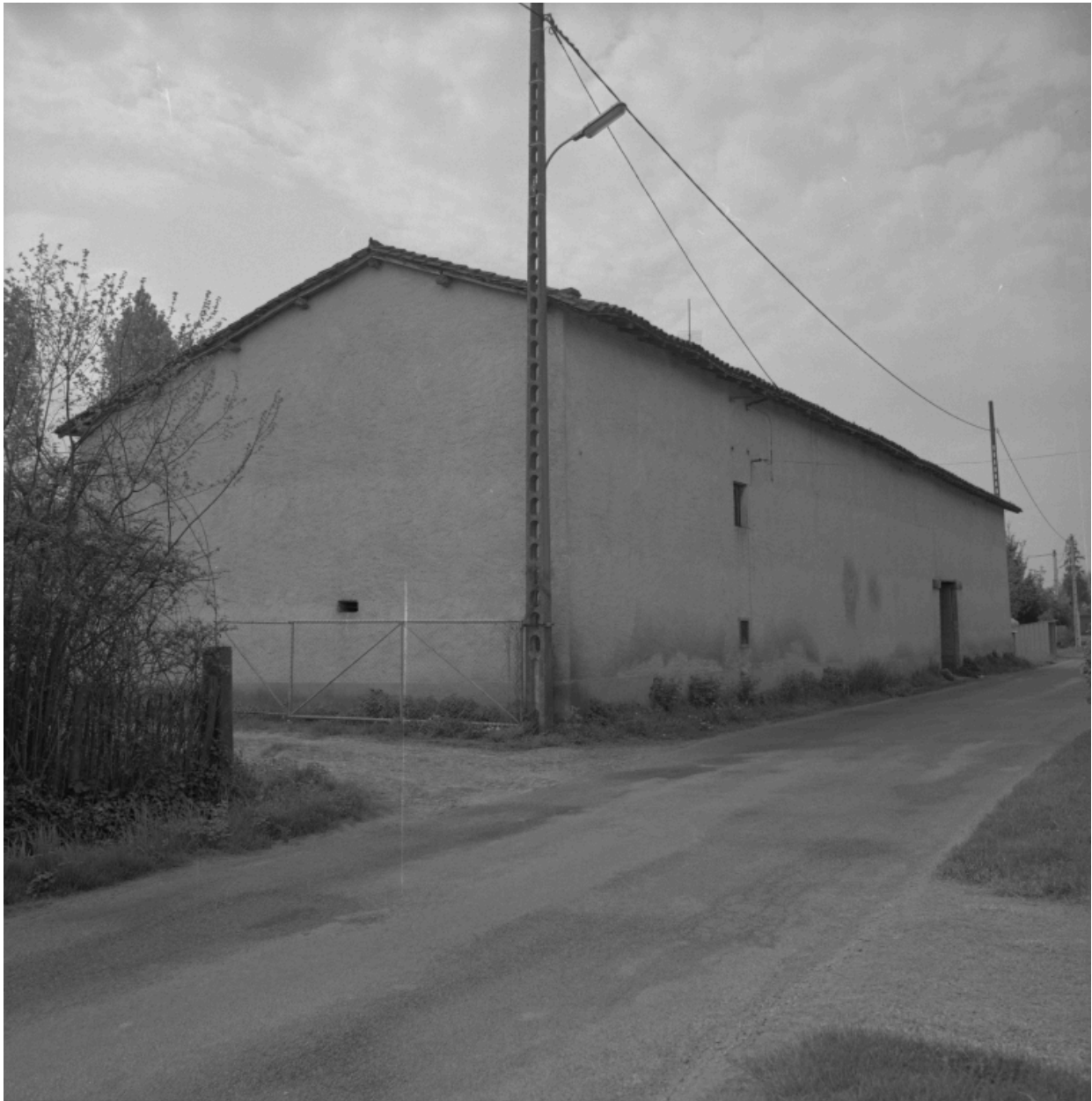
Ferme de type B, située sur la commune de Saint-Didier-de-Formans, lieu dit Pré du Renard, parcelle B1 16. Ferme construite dos à la route.
