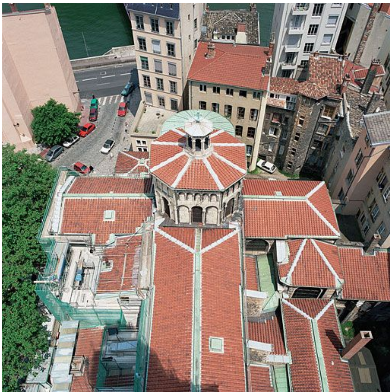
La toiture vue depuis le clocher
