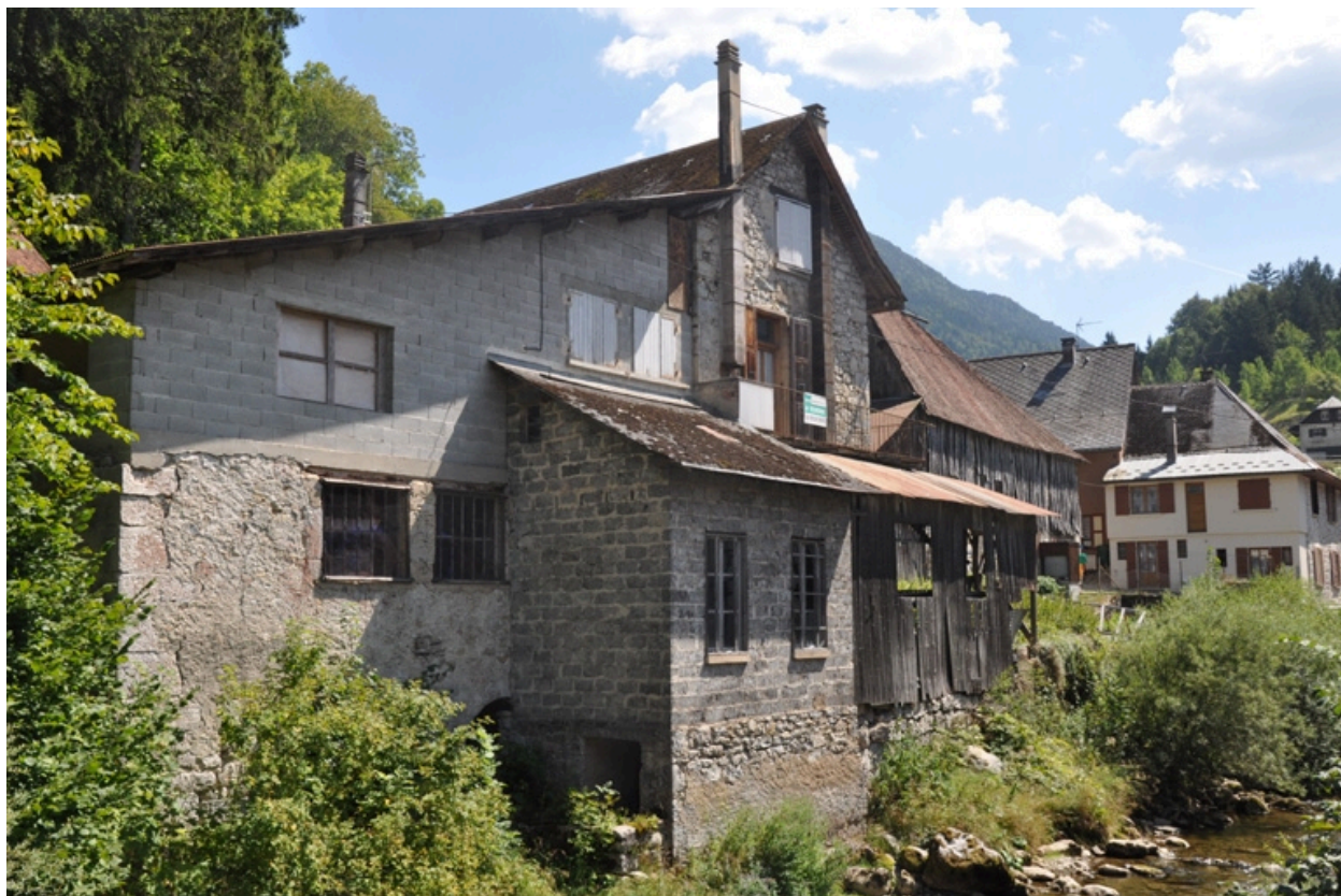
Vue générale du moulin, façade ouest
