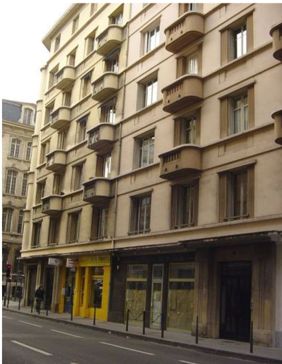
Vue de l'élévation rue de Sèze depuis le nord-est
