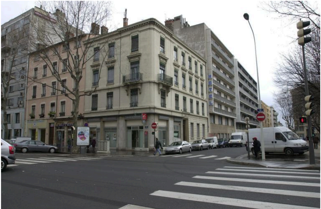
Vue générale depuis le sud-ouest
